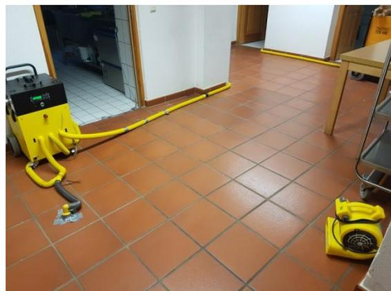
Die Trocknungsgeräte im Einsatz nach einem Wassereintritt im Keller
